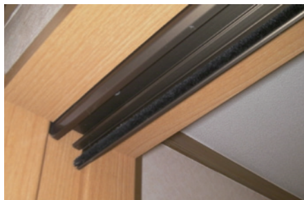
枠見込みと納まり確認
