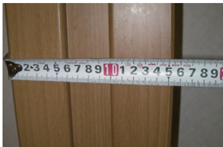
枠見込みと納まり確認
