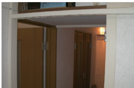
防音ドアの天井の取り合い確認
